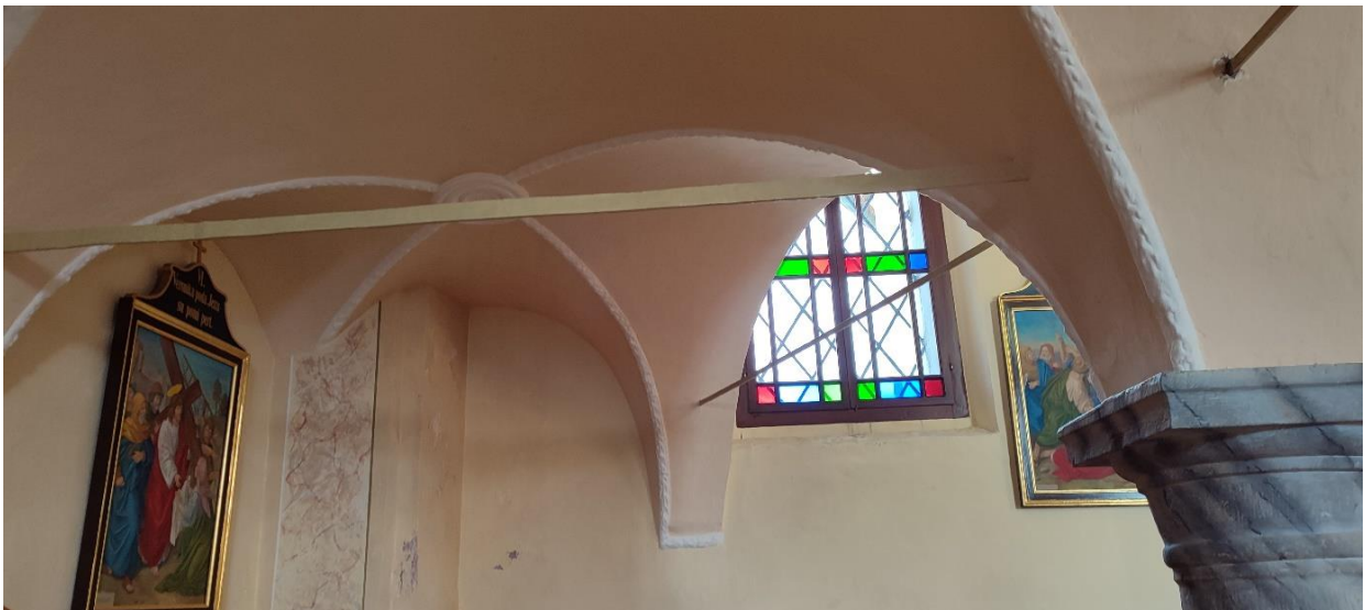
Slika 16: Zidan kor na stebri.
